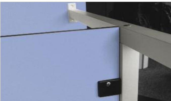
ANSCHLUSS TRENNWAND AN FORMROHR-STEHER
