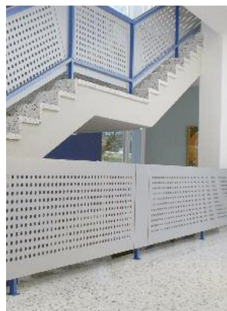
STIEGEGELÄNDER - LOCHFRÄSUNGEN
