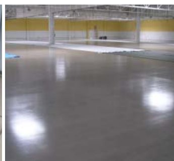
Vyrovnání průmyslové podlahy pod syntetickou stěrku
